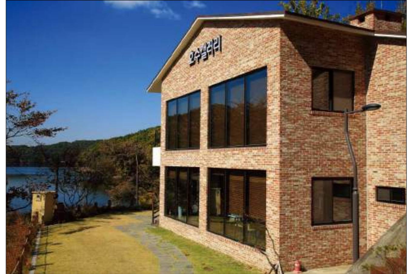
시공현장 적용 제품명 : 상산 고벽돌
