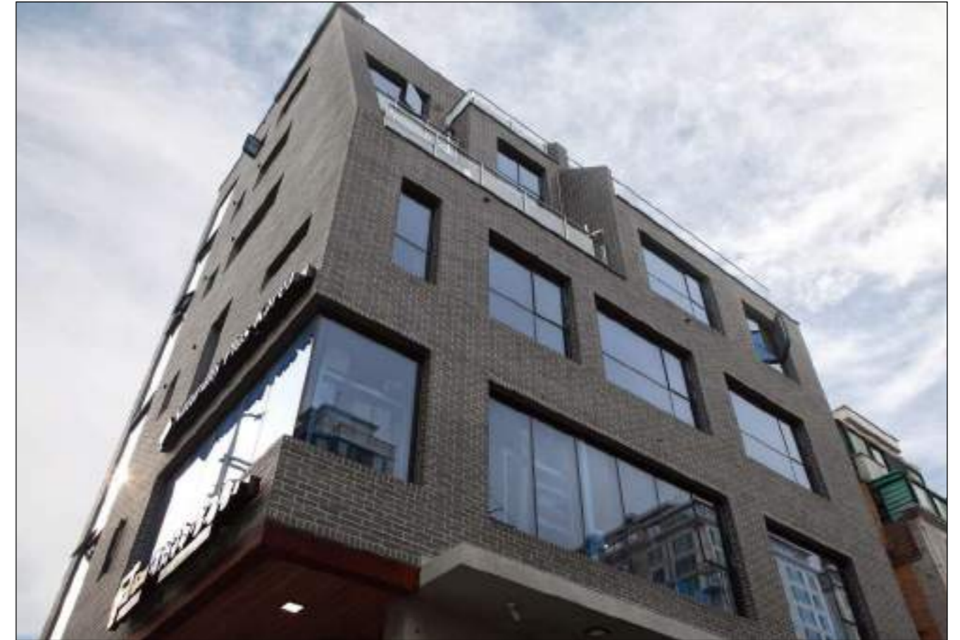
시공현장 적용 제품명 : 상산 미장 전벽돌
