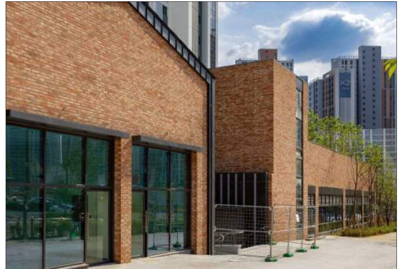
시공현장 적용 제품명 : 상산 고벽돌
